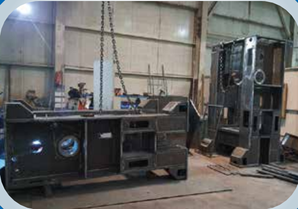
Kaynak Bölümü Welding Worshop
